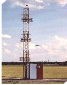
Figuur 17: Gs- antenne
