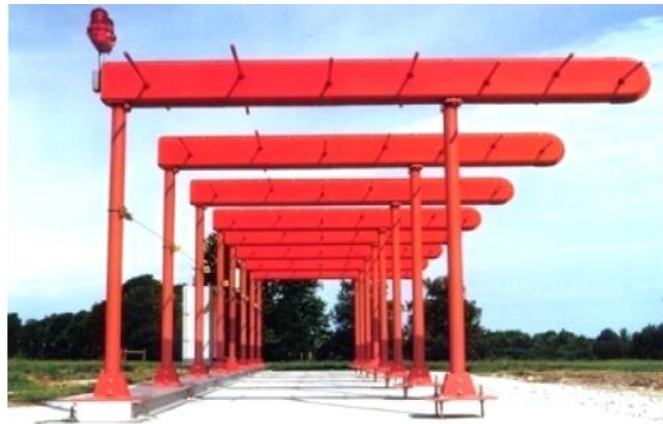
Figuur 11: Localizer Antenne-array
